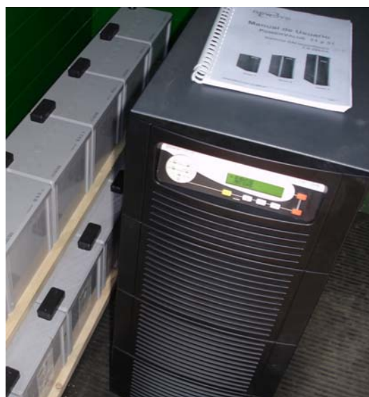
Fotos nº 1 y 2 : Exterior e interior de la caseta con la SAI y baterías.
