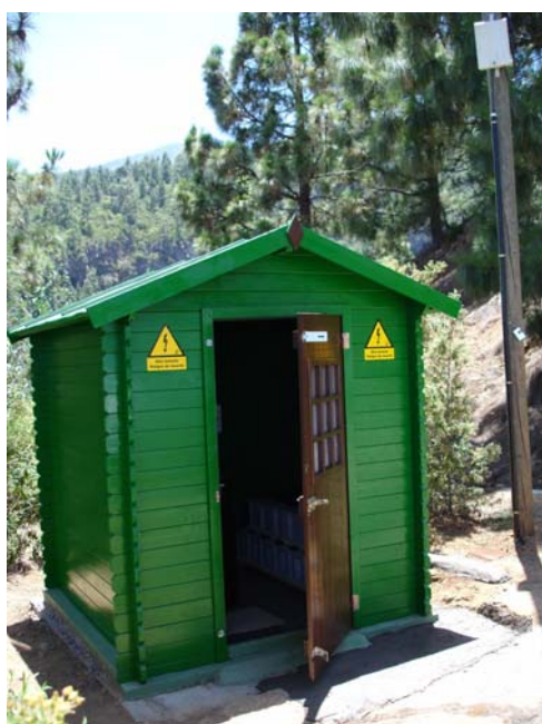
Fotos nº 1 y 2 : Exterior e interior de la caseta con la SAI y baterías.
